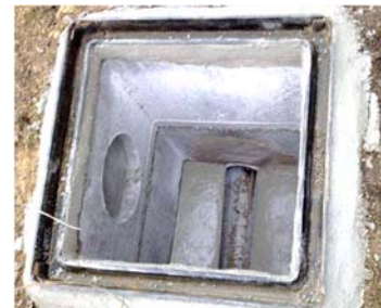
Figure 2: fond aménagé autour d'une demi canalisation, en cunette pour faciliter l'écoulement
